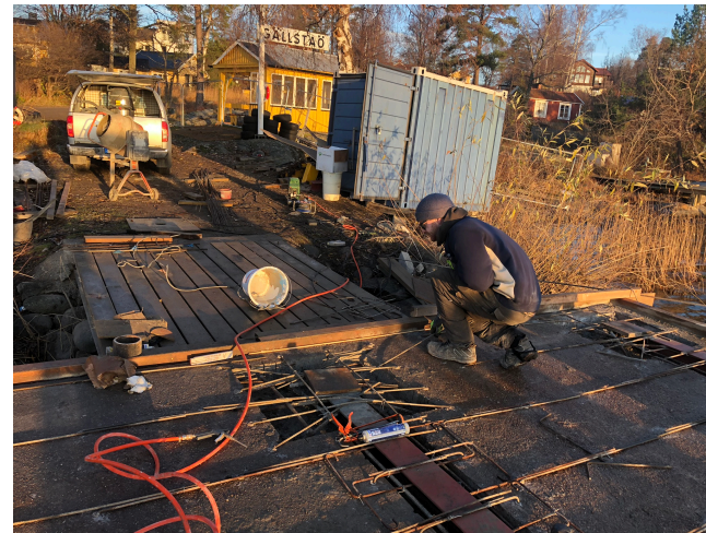
Arbetsgruppen för Gällstaös Ångbåtsbryggas renovering
